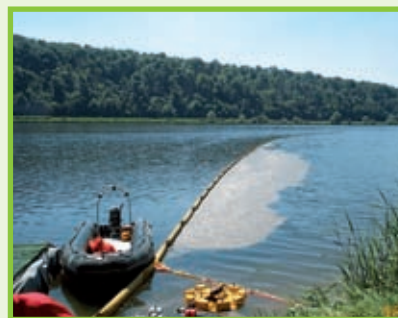
120 m de barrage flottant
