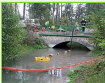
Mini barrage flottant en rivière
