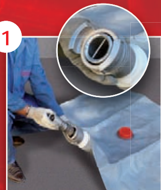
1 Déplier la cuve souple et vérifier que l'ajutage est bien dans son logement
