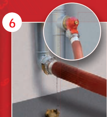
6 Mettre la colonne sous pression et effectuer les tests de pression
